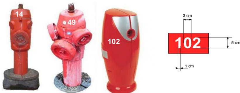
Numéro à apposer sur le coffre et sur le poteau lui-même
